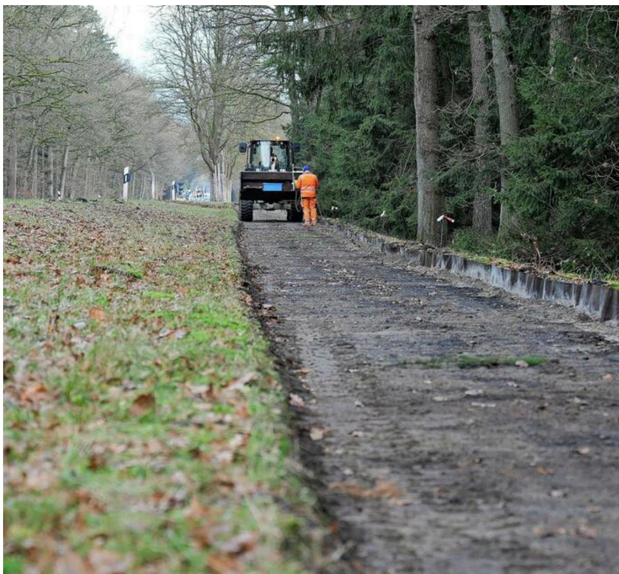
Südlich von Hassel entsteht derzeit ein neuer Radweg an der B3. Eine Wurzelsperrfolie (rechts) auf der Waldseite soll verhindern, dass Baumwurzeln den Asphalt erneut beschädigen. Foto: Sebastian Salpius
